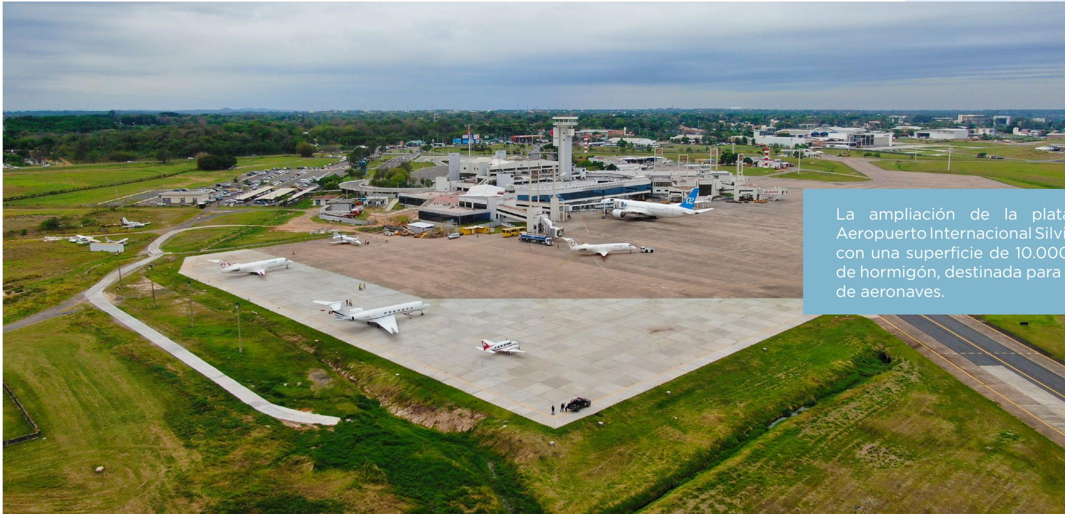
La ampliación de la plataforma norte del Aeropuerto Internacional Silvio Pettirossi, cuenta con una superficie de 10.000 m<sup>2</sup> de estructura de hormigón, destinada para el estacionamiento de aeronaves.
