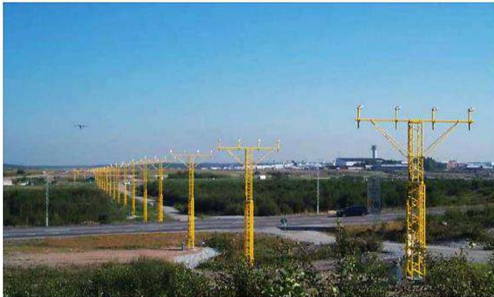
**Figura 2-6-2. Torres de iluminación de aproximación — Estructuras reticulares de fibra de vidrio.**
