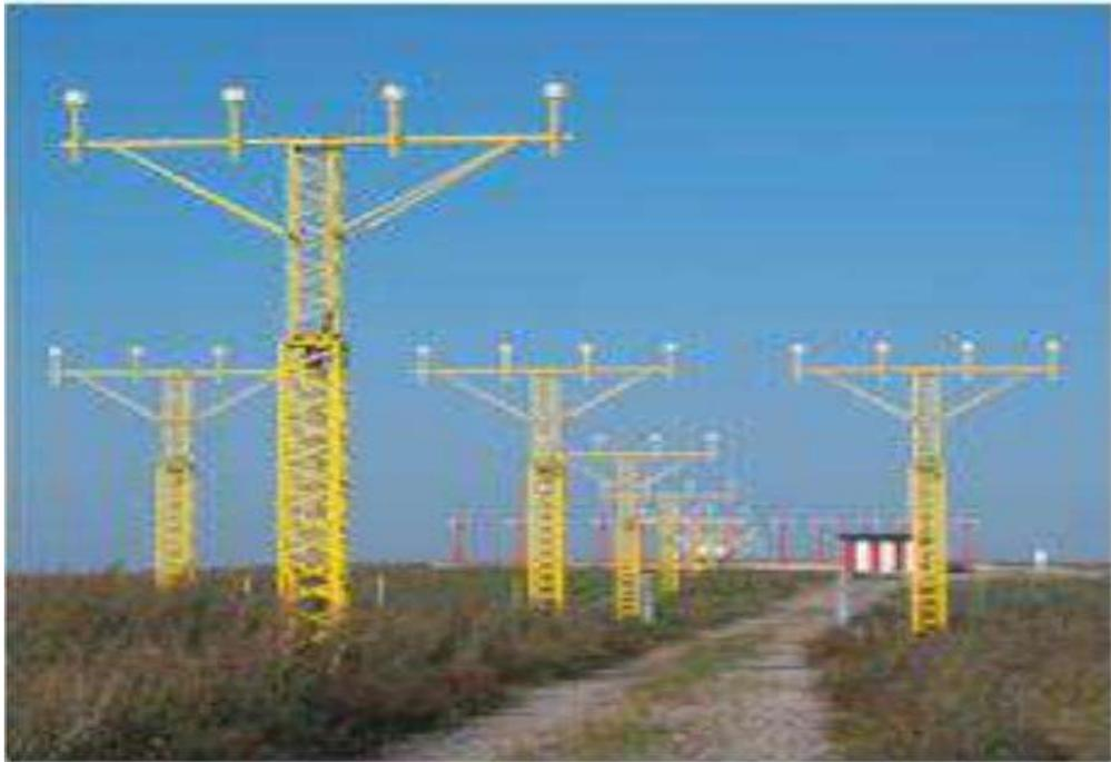
**Figura 2-8-2. Torres de iluminación de aproximación de fibra de vidrio.**
