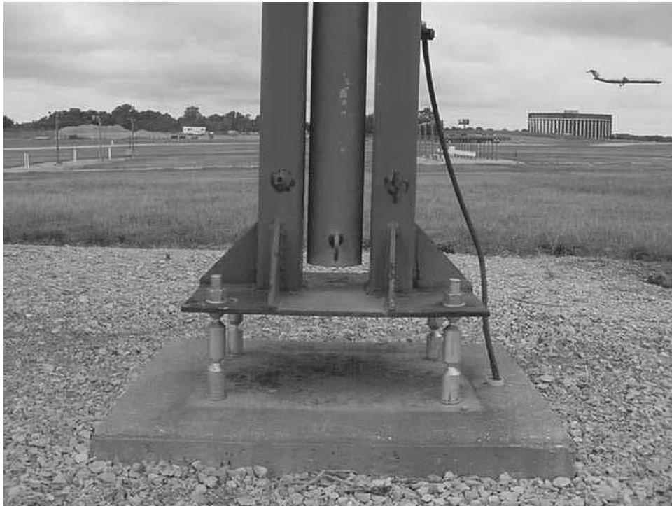
Figura 2-6-1. Perno fusible.-
