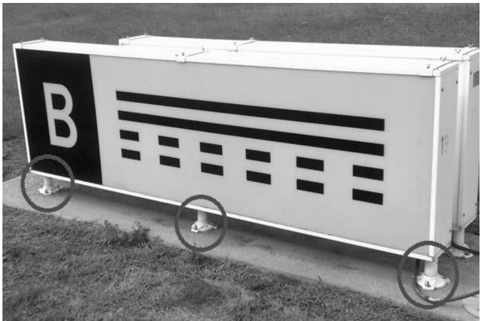
Figura 2-6-6. Ejemplos de cuplas Frangibles en las instalaciones de los Letreros.-
